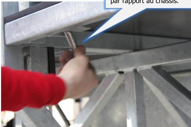
Engagement des deux verrous généraux situés sous la partie centrale du plancher à côté des bras antirenversement.
