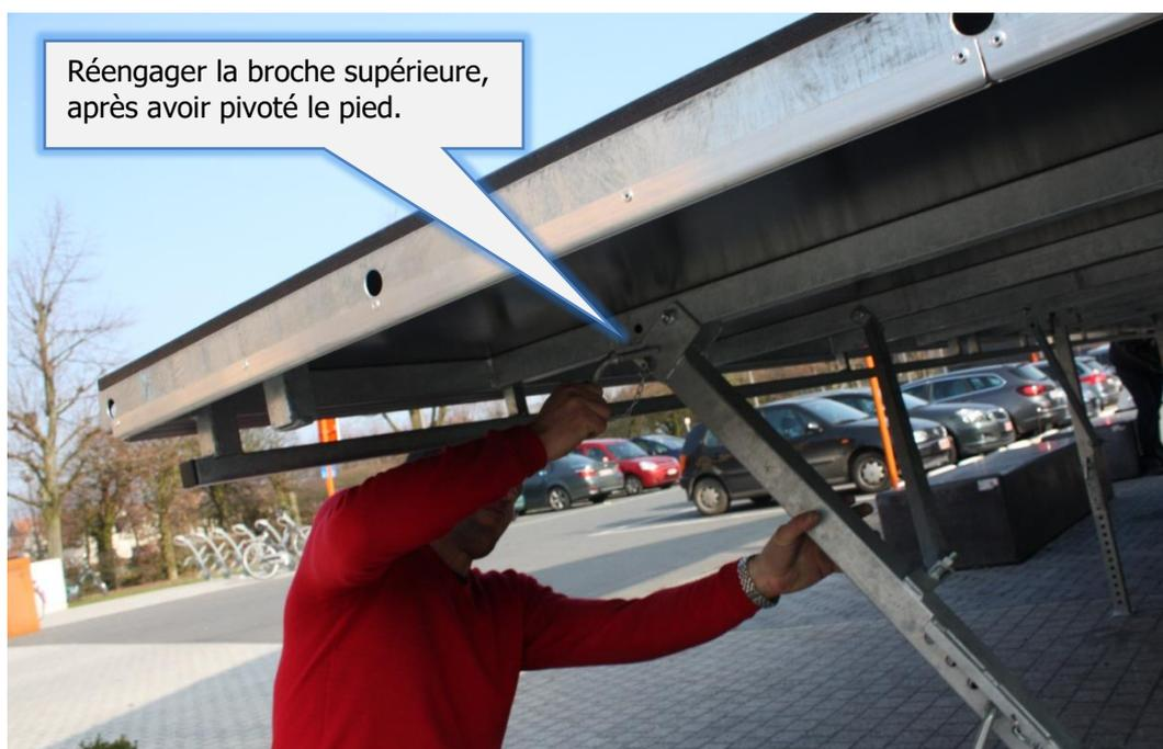
Les pieds extensibles sont inclinés et reverrouillés. Ceci permet leur pivotement lorsque l'abattant de plancher est relevé à la verticale.
