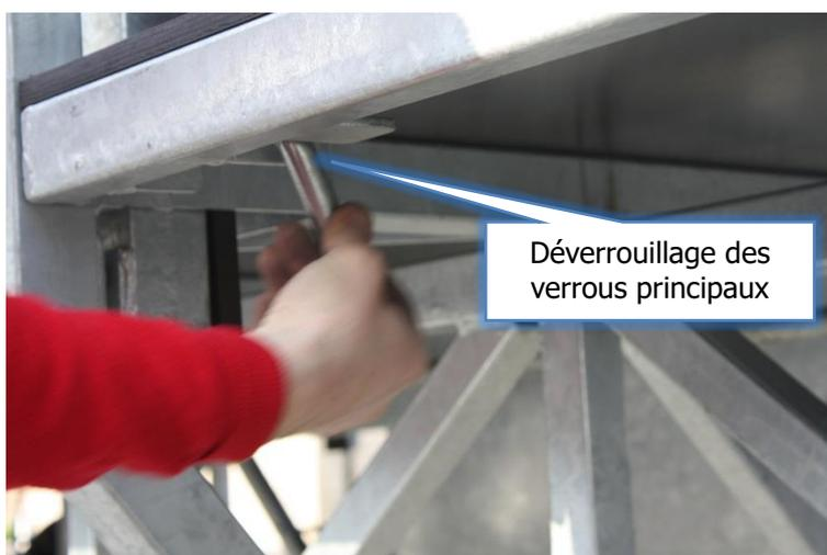
Retirer les verrouillages principaux qui se trouvent sous la partie centrale du plancher à côté des bras antirenversement. Il y a deux verrous par abattant.
