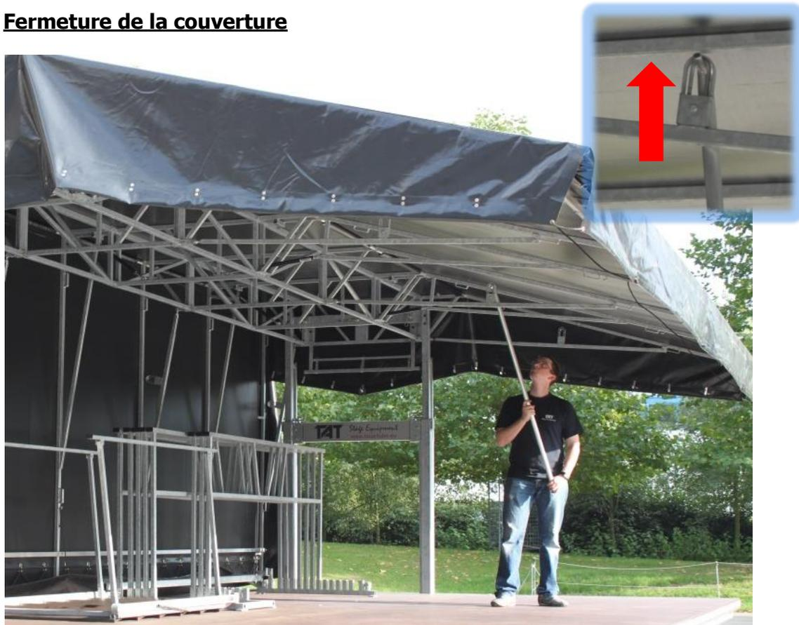
Désengager simultanément les dispositifs de verrouillage situés dans la couverture au moyen de la perche de maniement en aluminium.
