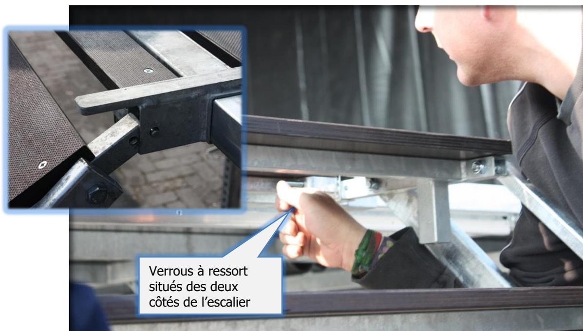
L'escalier peut être désaccouplé de la barre de fixation suite au retrait des deux verrous à ressort.
