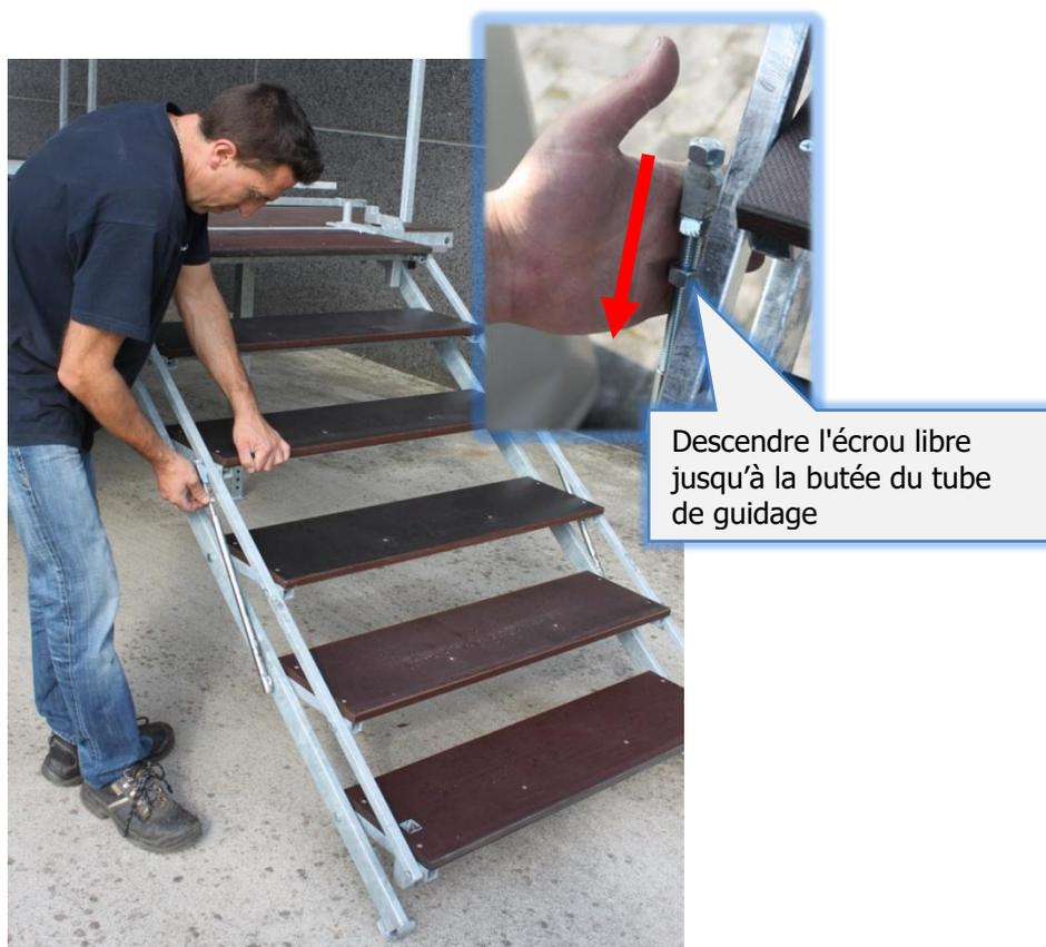
Les marches sont positionnées à l'horizontale et immobilisées en ajustant de part et d'autre l'écrou situé sur la tige filetée jusqu'à la butée du tube de guidage.
