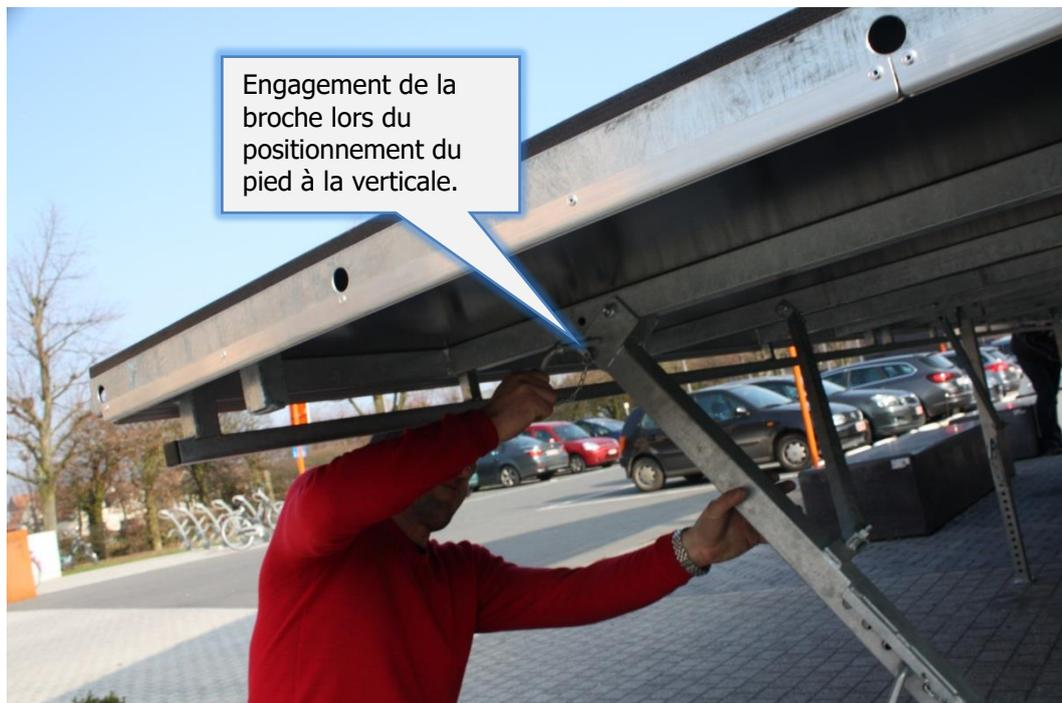
Pivotement et verrouillage des pieds télescopiques dans leur position verticale.
